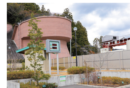
▲赤松水力発電所
