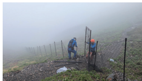
▲防鹿柵の設置
