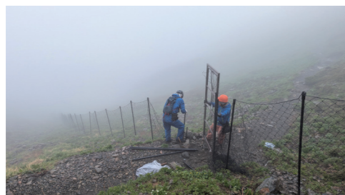
▲防鹿柵の設置
