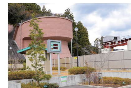
▲赤松水力発電所
